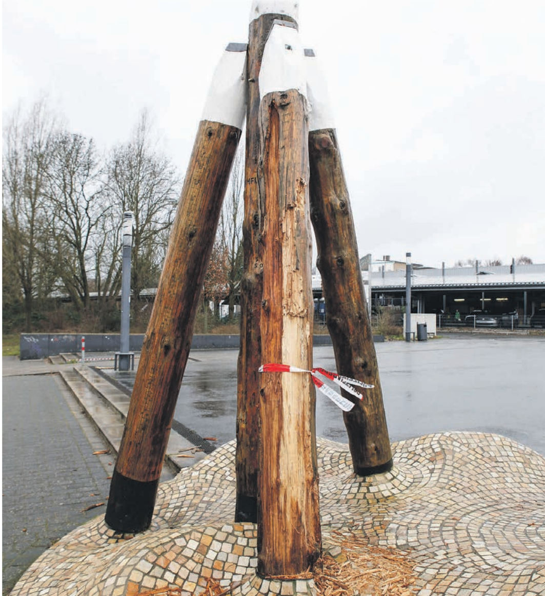
Nur das mittlere Holz ist noch in Ordnung. Als einziges besteht es aus Douglasie.
