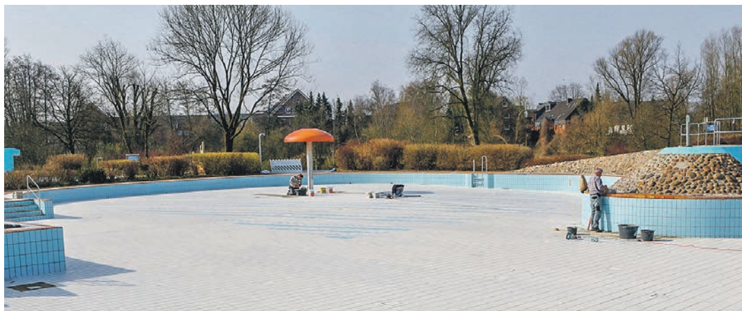
Im Spaßbecken laufen die letzten Arbeiten, bevor es für die Saison geflutet wird.
