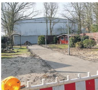
Noch Baustelle: Der neue Zugang im Krückapark, quasi auf der Rückseite des Hallenbads.
