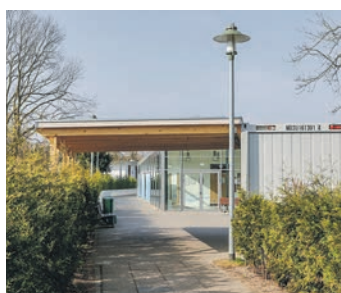
Das neue Kassenhäuschen steht kurz vor dem modernen Umkleedekret.
