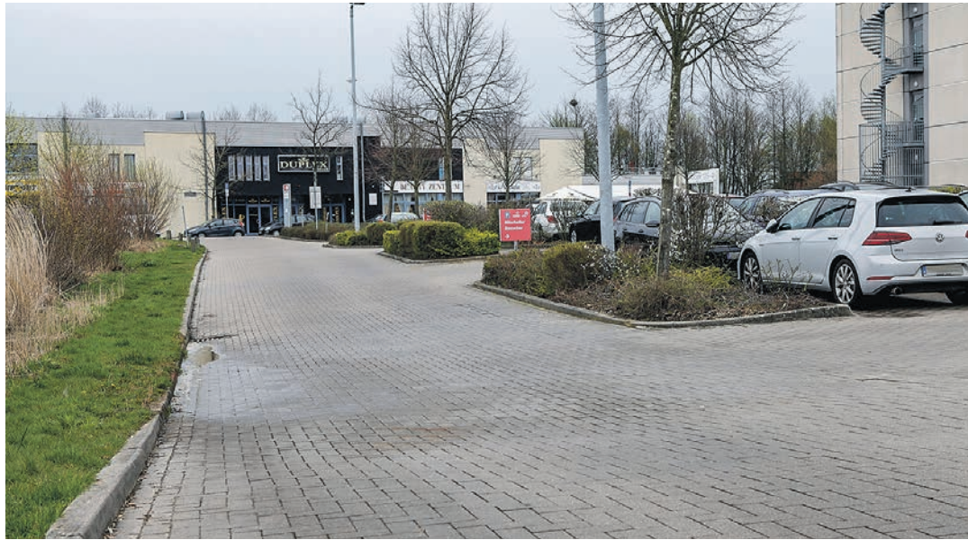
Die Versackung der Zufahrt links im Bild ist deutlich zu sehen.
