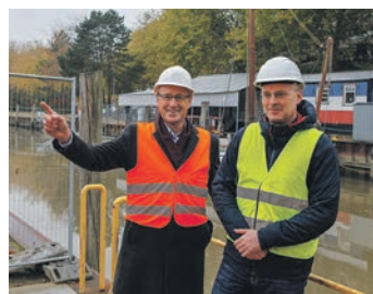
Bürgermeister Volker Hatje (li.) und Elmshorns „Mr. Wasser“ Thomas Beiersdorf am Ablauf in die Krückau. Beide freuen sich, dass die Entwässerung künftig deutlich sicherer wird.
